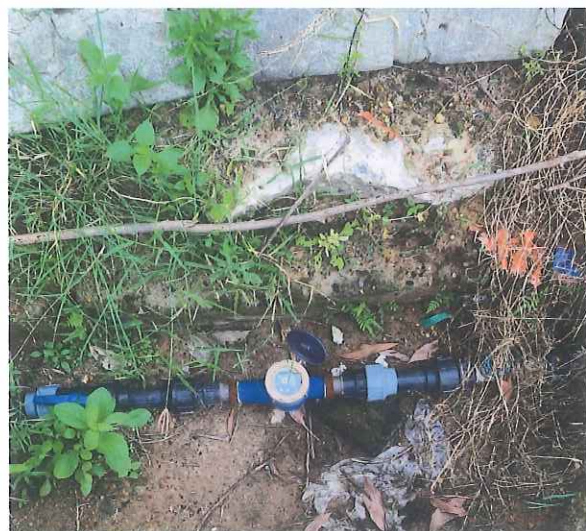
Đồng hồ đo lưu lượng nước thải kết nối vào HTXL KCN Quảng ngang
