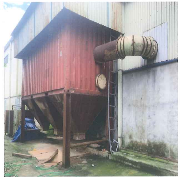
Hệ thống thu gom, xử lý và thoát bụi, khí thải
