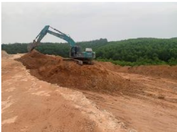
Hiện trạng công trường đang khai thác
