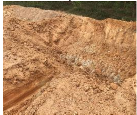
Hố lắng nước mưa chảy tràn trên công trường
