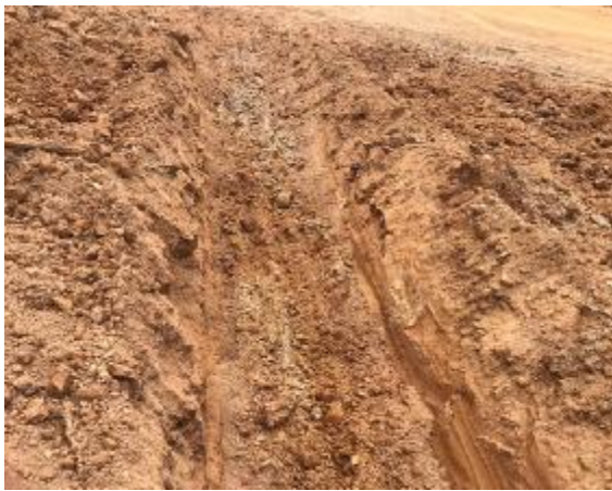
Rãnh thoát nước mưa
