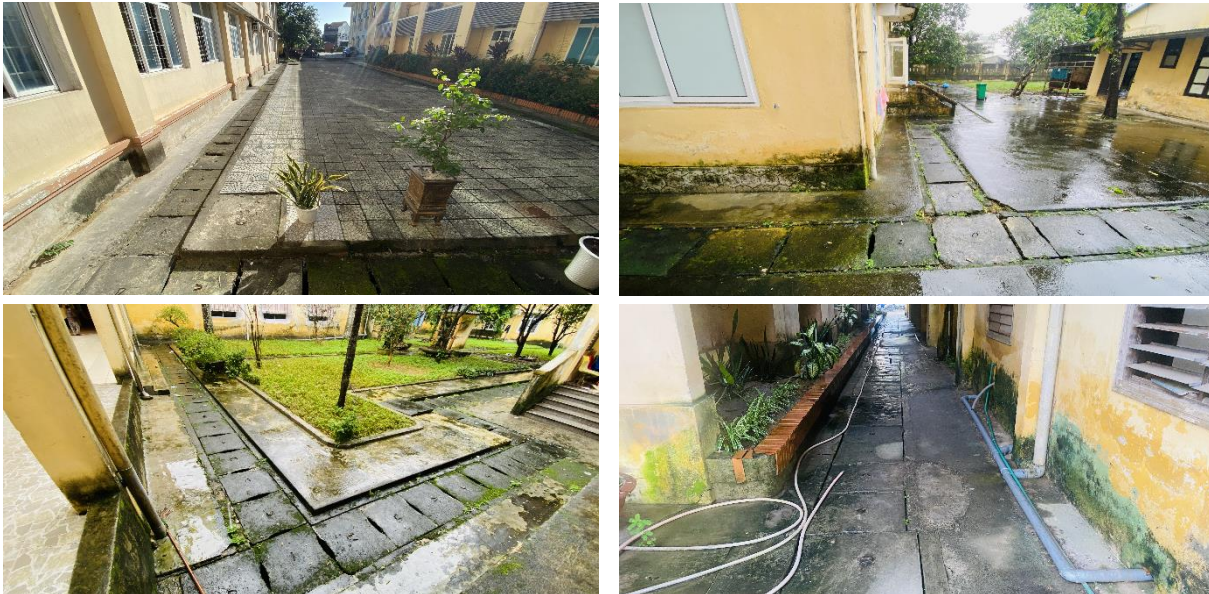
Hình 3.1. Mương thu gom và thoát nước mưa trong khuôn viên Bệnh viện
