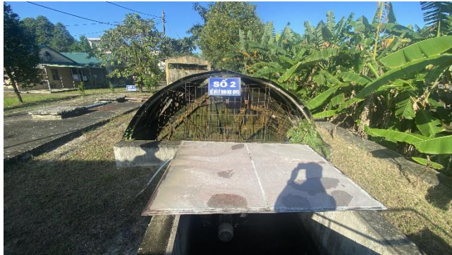
Bể phản ứng RBC
