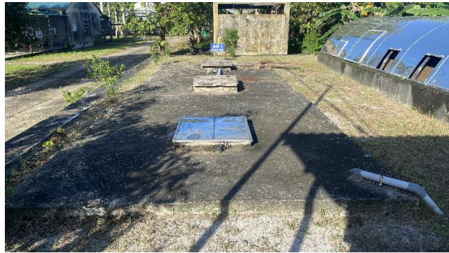
Bể lắng 1 (PST)
