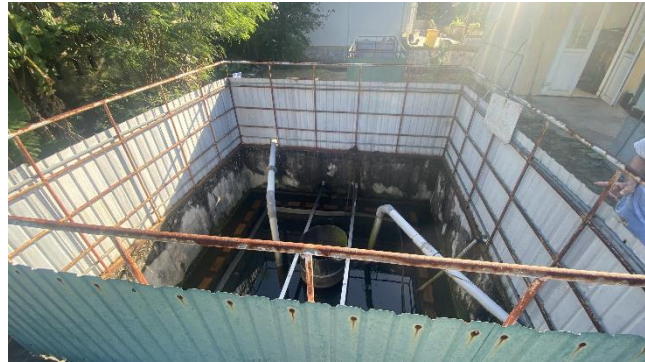
Bể lắng 2 (FST)
