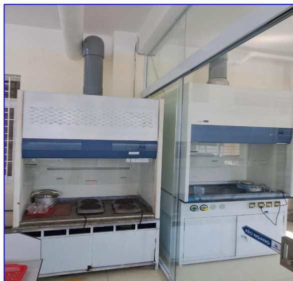
Hình 9: Hệ thống thu gom khí thải tại Cơ sở
