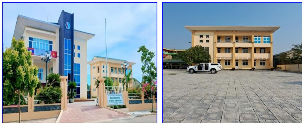
Hình 1: Hiện trạng công trình Trụ sở
