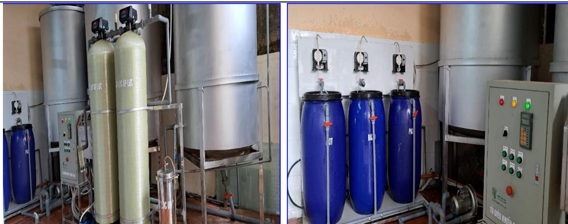
Hình 8: Hệ thống xử lý nước thải tập trung
