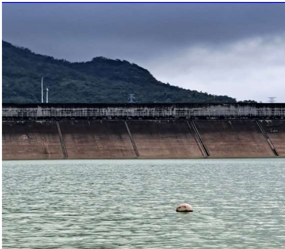
Đập dâng công trình
