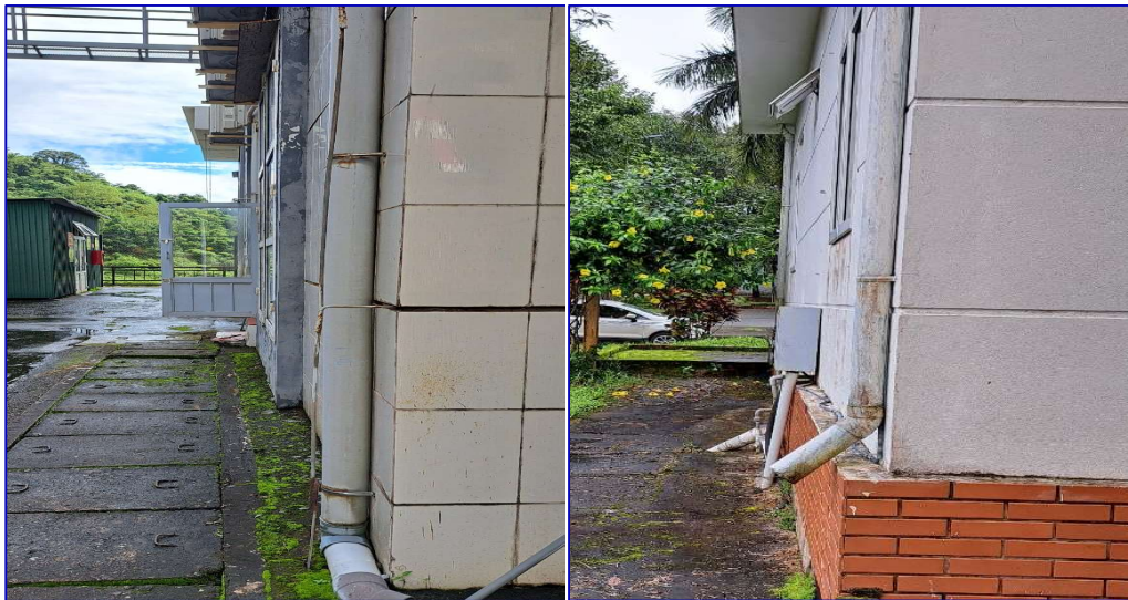
Hệ thống thu nước mưa từ tầng mái tại các khu nhà
