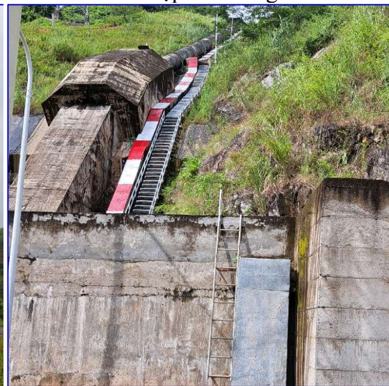
Ống dẫn nước sau tháp điều áp
