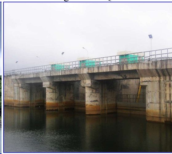
Cửa vào đập tràn công trình
