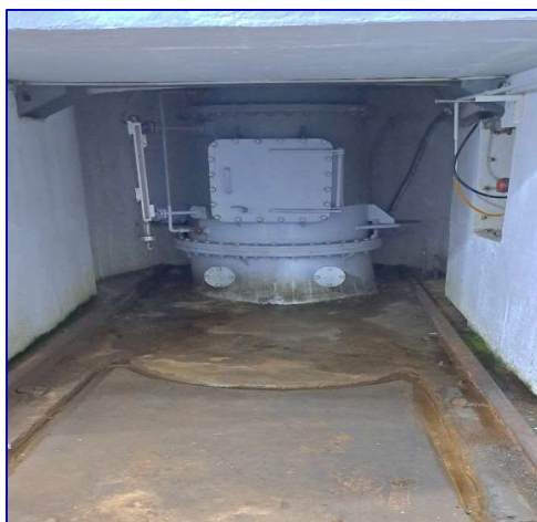
Rãnh thu gom nước lẫn dầu mỡ
