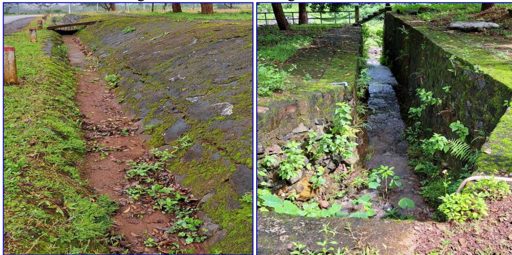
Hệ thống mương dẫn nước mưa ra khu vực tiếp nhận
