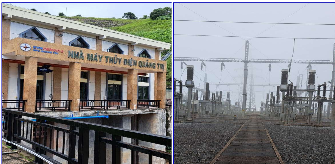
Nhà máy Thủy điện
