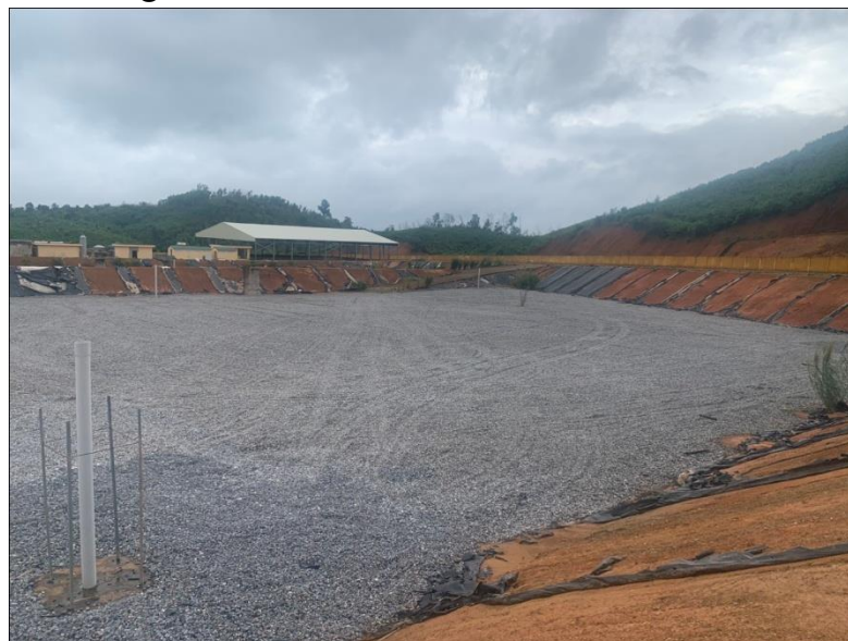
Hình 3.9. Hình ảnh Bãi chôn lấp chất thải rắn thông thường
