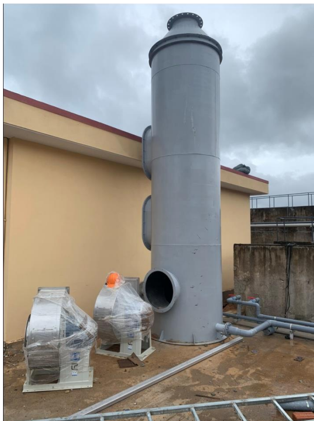
Hình 3.4. Hình ảnh tháp Tháp Stripping
