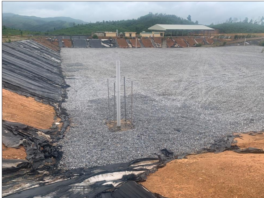
Hình 3.8. Hình ảnh ống thu khí rác
