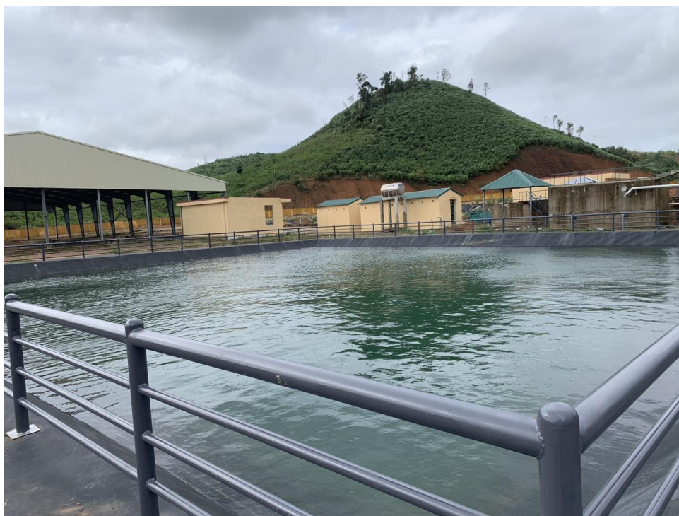
Hình 3.3. Hình ảnh Hồ chứa nước rỉ rác
