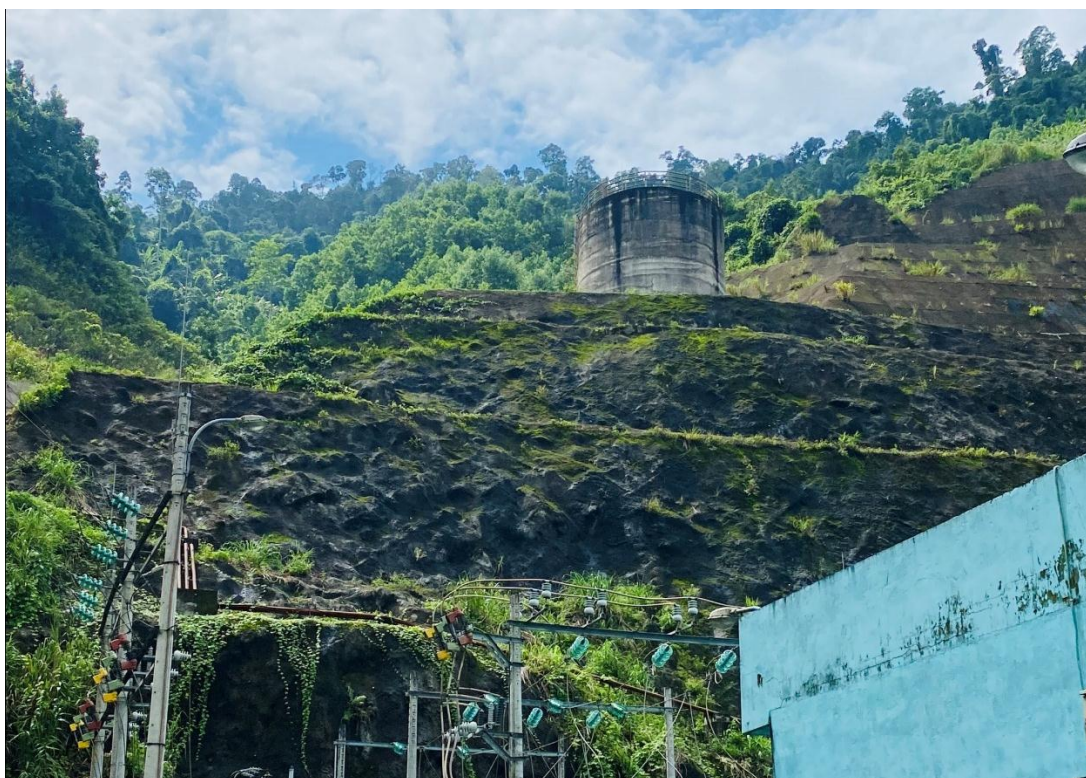
Hình ảnh 3.8. Giải pháp gia cố chống sạt lở
