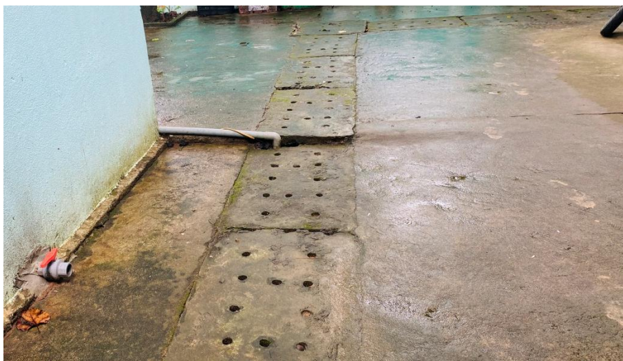
Hình 3.1. Mương thu gom và thoát nước mưa tại Nhà quản lý
