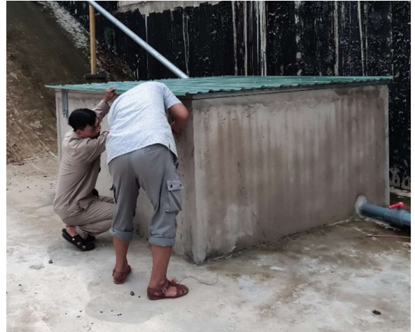
Bể gom dầu sự cố ở máy biến áp
