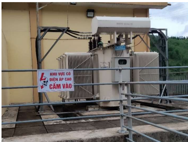
Bể gom dầu sự cố ở máy biến áp
