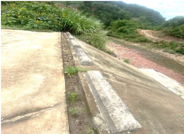
Cống, rãnh bê tông ở nhà máy thủy điện
