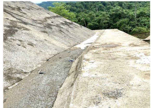
Mương thu nước mưa ở đập dâng
